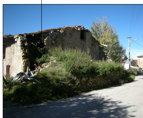
P.Illa 46 e Edificio Demolito
